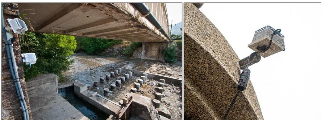
*Figure 1 : Exemple d'installations de transmetteurs sur supports inox*
